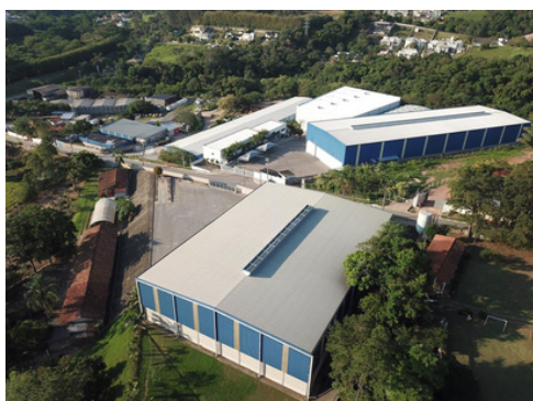
Instalações da DINOPLAST na década de 2.000
